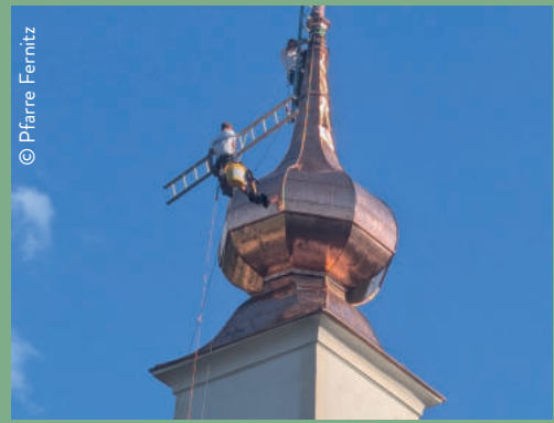
St. Jakob - Turmrenovierung
